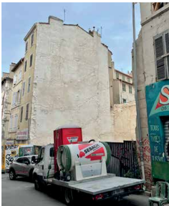
La dent creuse sur le site des effondrements de la rue d'Aubagne. © William Allaire
