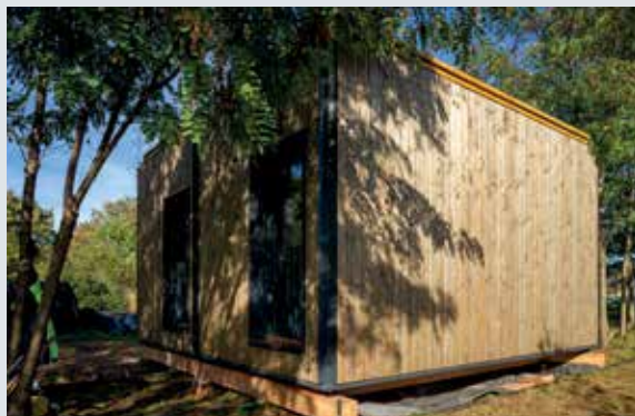
Les BMM doivent pouvoir être déplacés au moins deux fois sur leur durée de vie estimée à 50 ans. © Fabrice Singevin ICF Habitat
