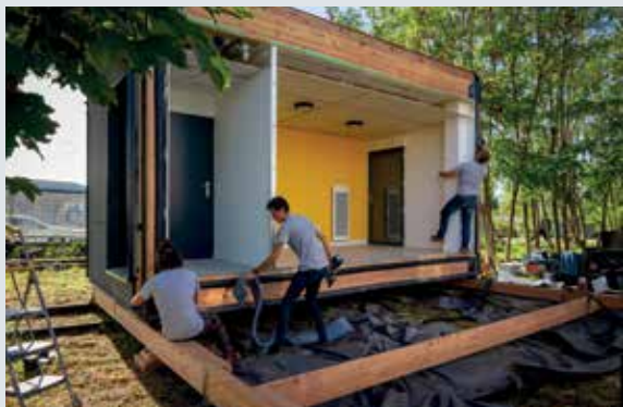
Planchers, poteaux, murs et charpentes sont construits en ossature bois. © Fabrice Singevin ICF Habitat
